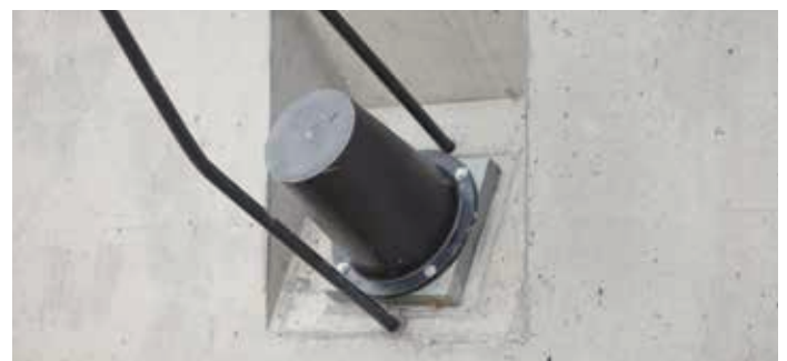
Ankerkopf bei Spann-Nische in Stützmauer. Injektions- und Entlüftungsleitungen werden im Endzustand abgeschnitten.
